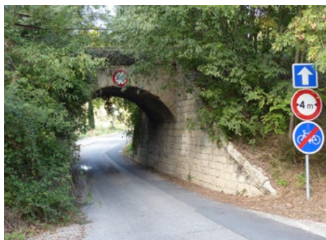
Pont SNCF, chemin de Sigaliès
